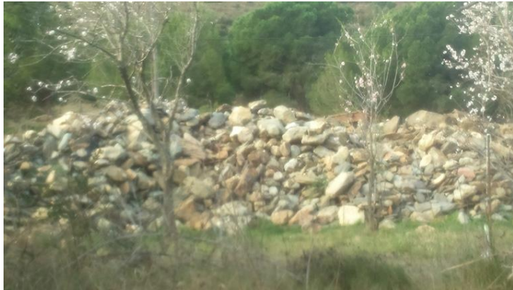
Foto realitzada des de la platja on s'observa l'apilonament de pedres en l'àmbit on no estava autoritzat realitzar moviments de terra.
