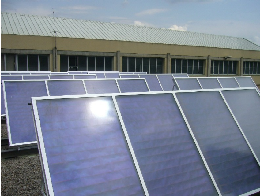
Piscina i pavelló de Palau
